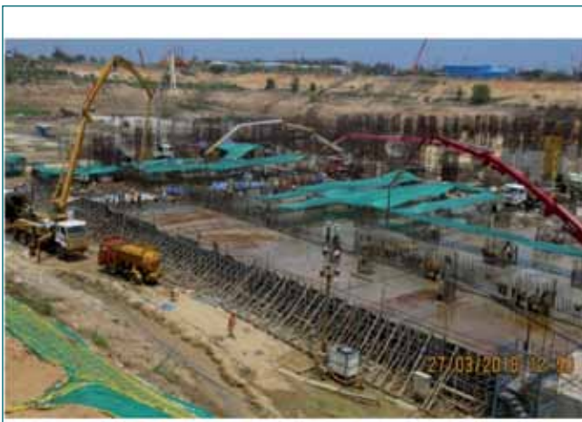
Fig. 1 Completed pour at FRP Block 1
