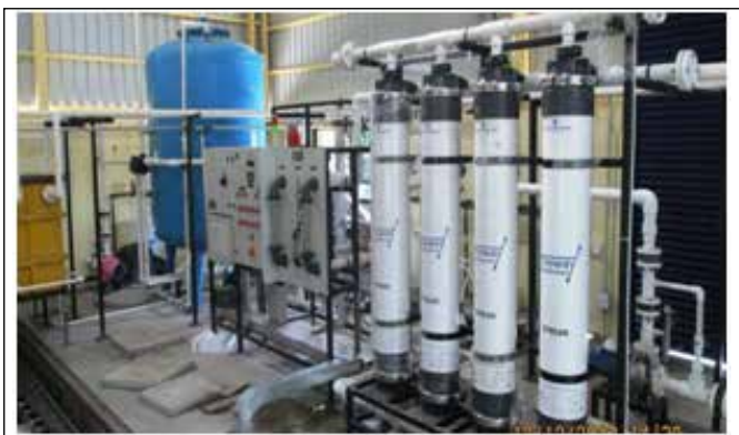
Fig.1: TTP with Original UF Membranes in Skid-2
